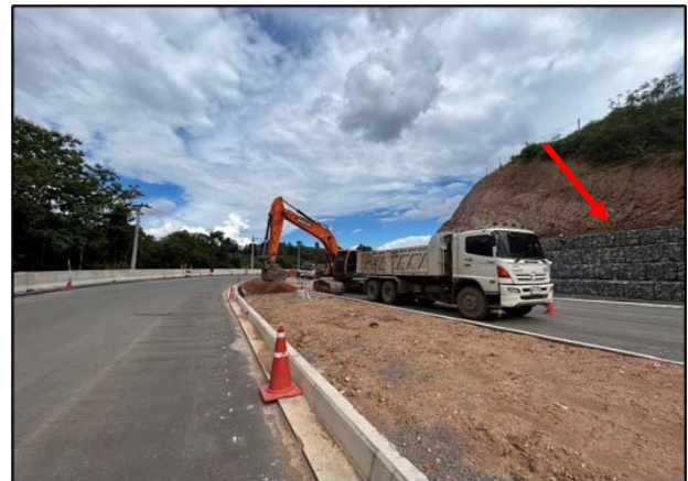
รูปที่ 2.1-3 กำแพงกันดินแบบ Gabion
