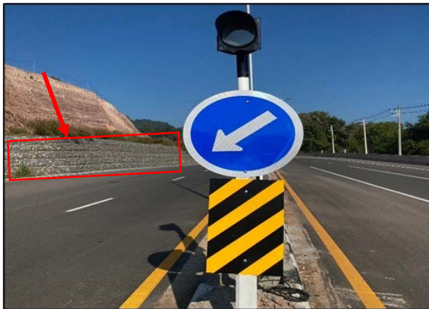
รูปที่ 2.1-3 กำแพงกันดินแบบ Gabion
