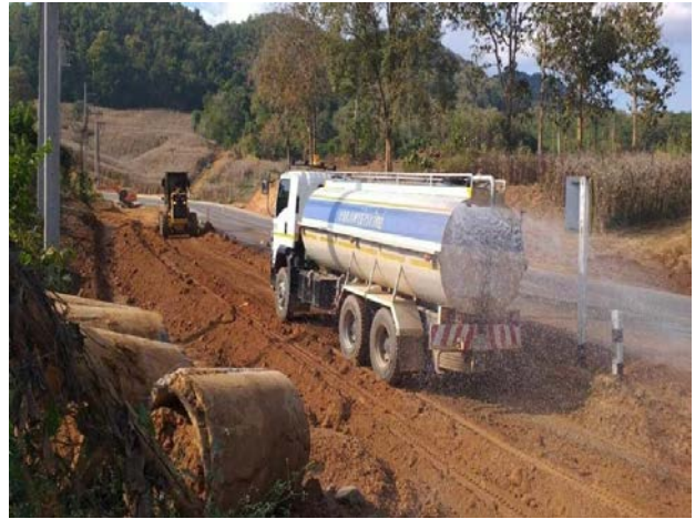
รูปที่ 2.1-6 รถฉีดพรมน้ำบริเวณพื้นที่ก่อสร้าง
