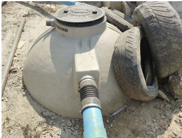
รูปที่ 2.1-13 ระบบบำบัดน้ำเสียสำเร็จรูปบริเวณ สำนักงานโครงการ
